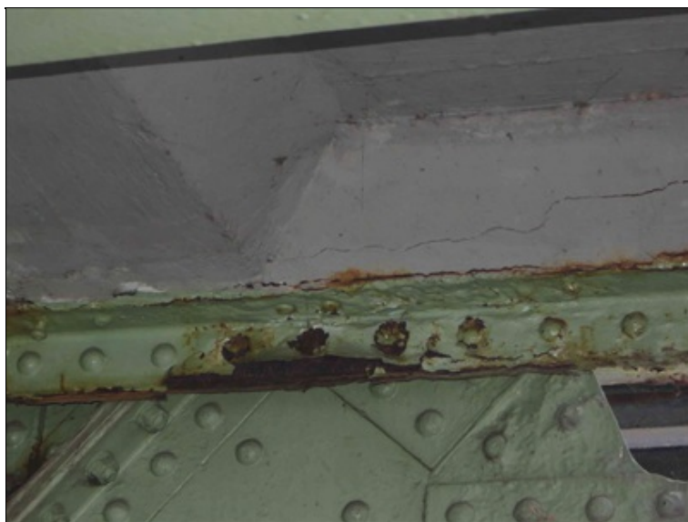
trhliny v nátěhu desky, intenzivní koroze krajního podélníku
