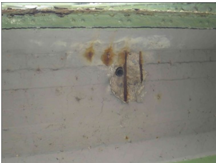
degradace betonu a koroze výztuže v místě průsaku v okolí trubky odvodnění povrchu izolace
