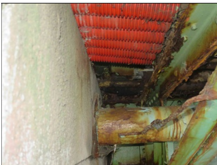
stávající stav IS v oblasti dilatační spáry nad O1 pod pravým chodníkem
