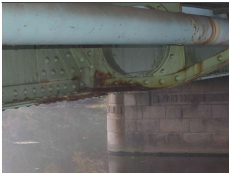
intenzivní koroze v místě styčnicku (konzola chodníku a spodní pás příhradového hlavního nosníku)
