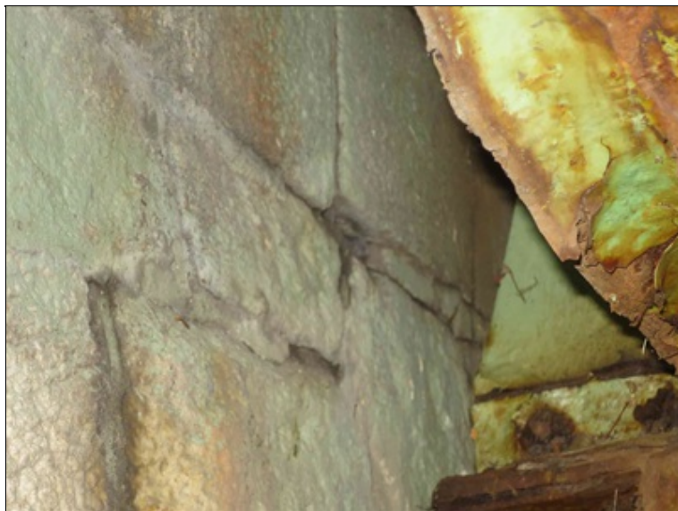
porušené spárování zdiva závěrné zídky O3
