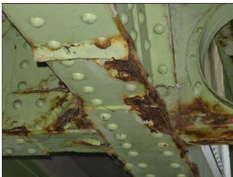
intenzivní koroze v místě styčnicku (příčnick a spodní pás příhradového hlavního nosníku)
