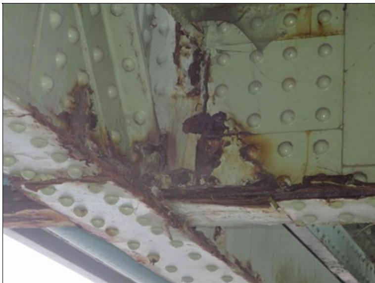
intenzivní koroze v místě styčnicku (příčnicku a spodního pasu příhradového hlavního nosníku)
