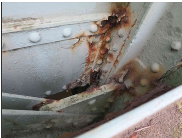
intenzivní koroze v místě styčnicku (římsový plech mostovky a svislice příhradového hlavního nosníku)
