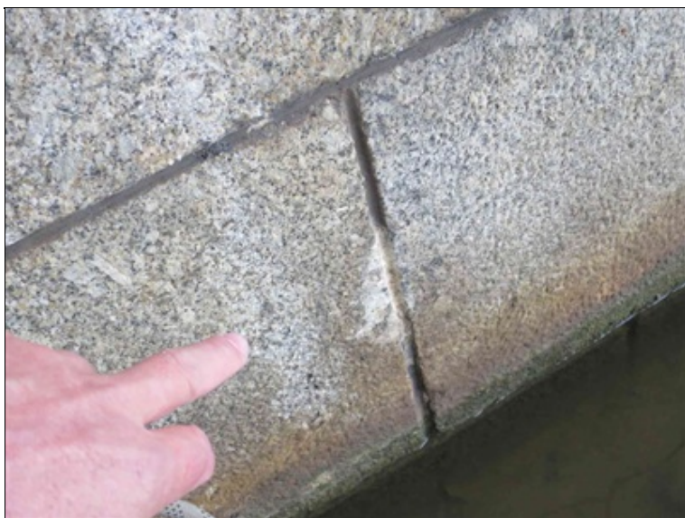
výluh pojiva na líci zdiva O1 v oblasti spáry v úrovni kolísání hladiny Radbuzy
