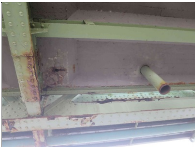
stopy po průsaku deskou mostovky, následná degradace betonu a koroze výztuže desky intenzivní koroze v místě styčnicku (příčník a spodní pás příhradového hlavního nosníku)
