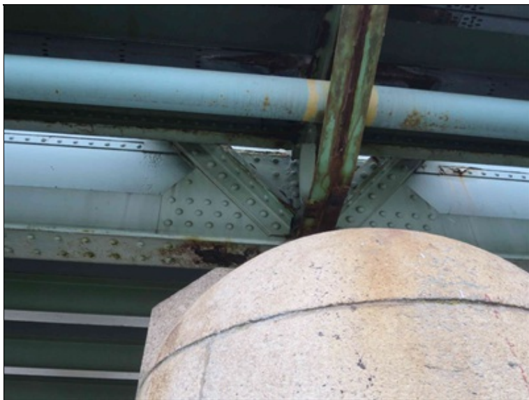
stav NK nad pravým ložiskem na P2
