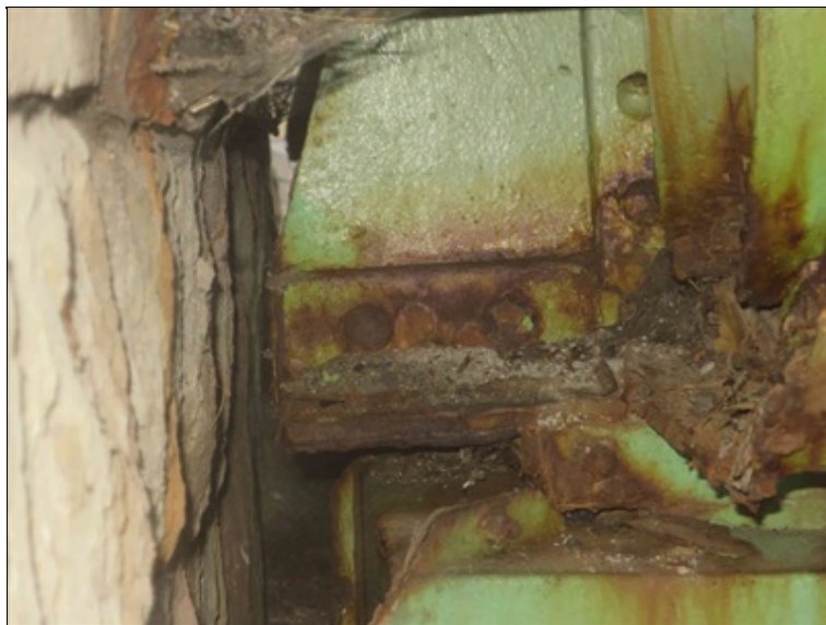
intenzivní koroze všech dotčených částí ocelové konstrukce v oblasti dilatační spáry nad O1
