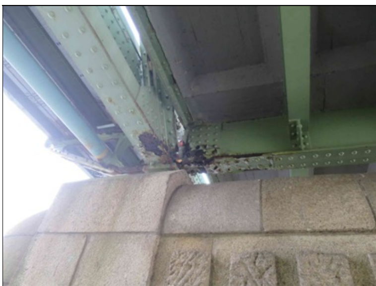
DTTO - intenzivní koroze v místě styčnicku (podporový příčník a spodní pás příhradového hlavního nosníku)
