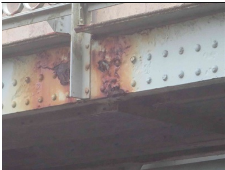
totální koroze vnějšího římsového plechu chodníku
