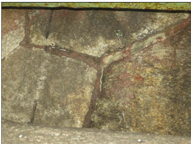
drobné poruchy spárování zdiva závěrné zídky O1
