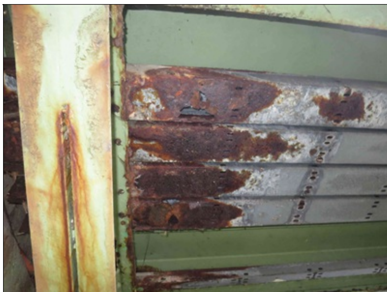
intenzivní koroze chrániček IS v oblasti dilatační spáry nad O3
