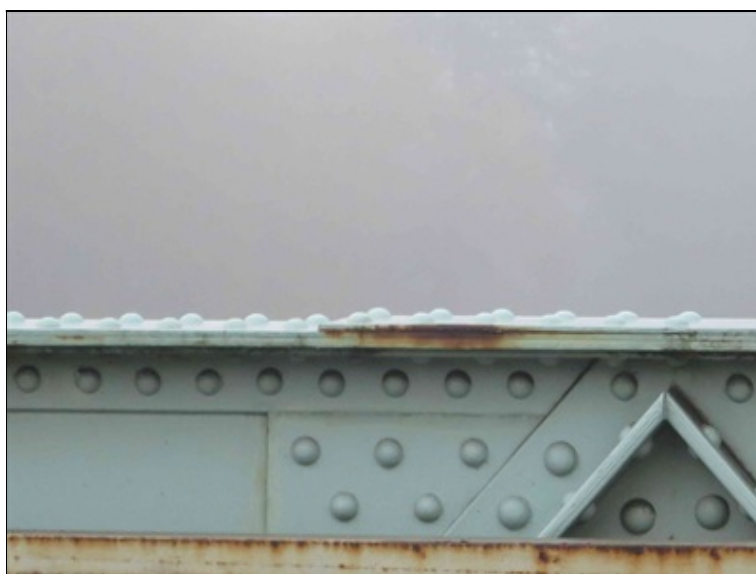
štěrbinová koroze horní pásnice hlavního nosníku
